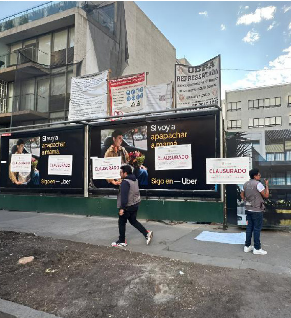
Clausura temporal total de una obra. Imposición de la medida de seguridad por incumplimiento a la normatividad ambiental aplicable en la Colonia Polanco IV sección Polanco, Miguel Hidalgo. Enero 2025. Foto: CIVASU
